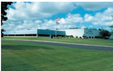
TESCOM Zentrale, USA
